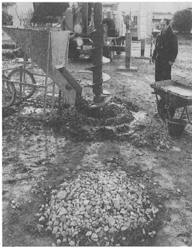
一戸建て住宅の新築でも地盤強化の工事が注目を集めている(埼玉県内)
