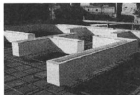
▲同じトータルコストで断熱性能を向上させられる「タイト・モールド」。
